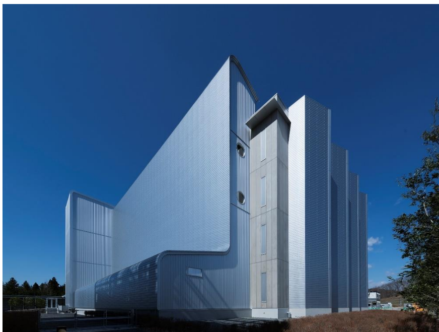
白河データセンター5号棟
