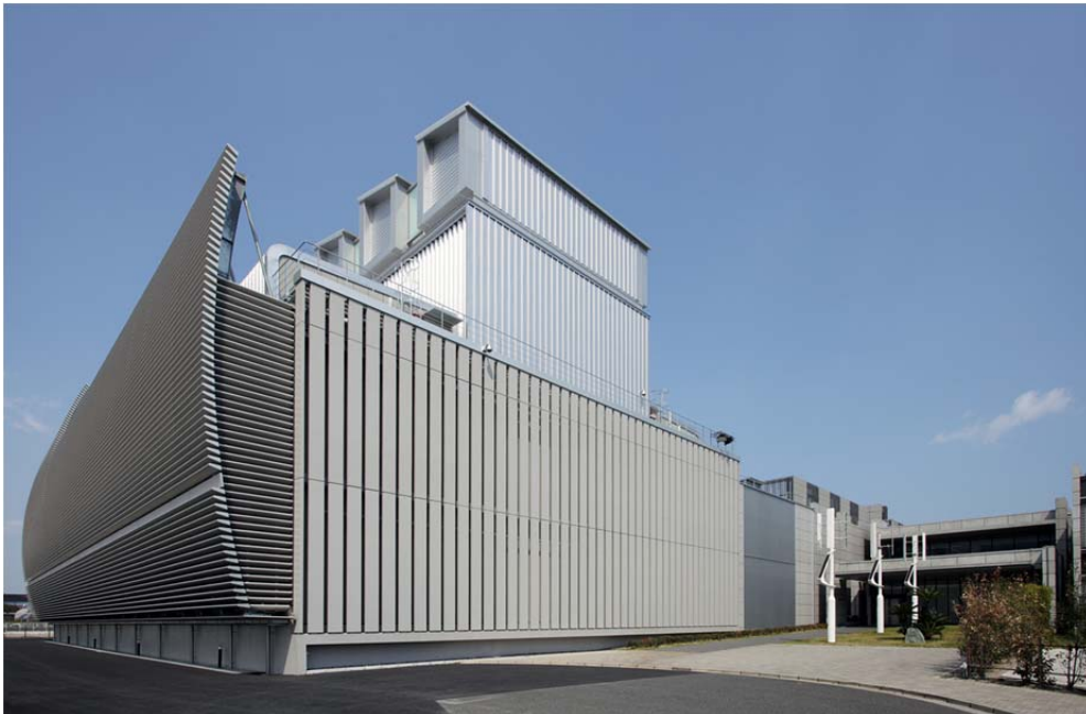
北九州データセンター5号棟
